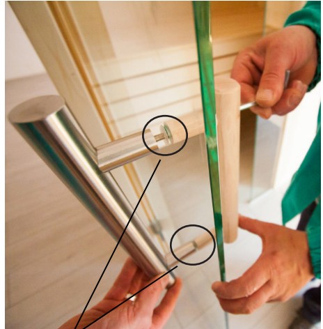
Kunststoff-Beilagscheiben bei Niro-Griff beilegen
