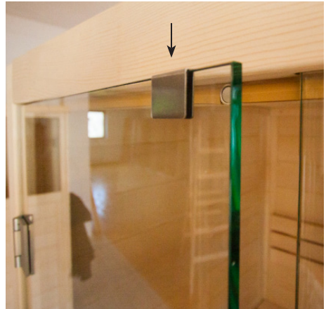
Kunststoff-Beilagscheiben bei Niro-Griff beilegen
